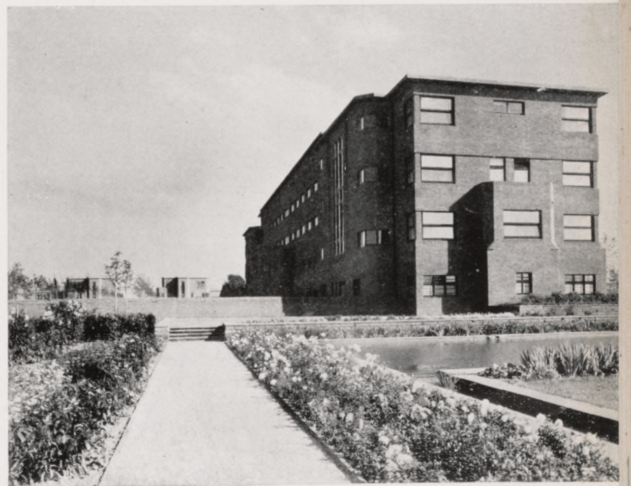
Vue du bâtiment principal, prise du Nord-Ouest.
