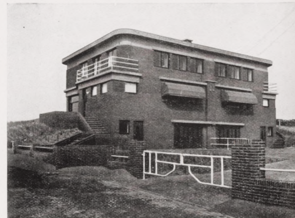
Double villa au Zoute. Vue générale.
