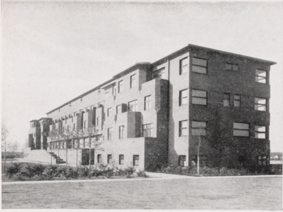
Vue du bâtiment principal, prise du Sud-Est.
